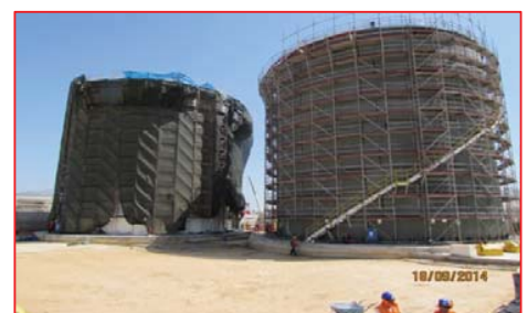
Trabajos de acabados en tanques de combustible
