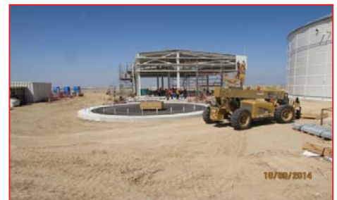
Montaje en el área de tanques de agua
