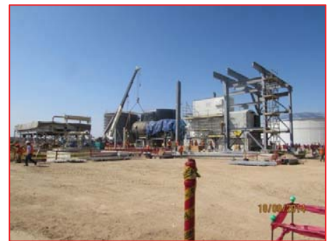
Trabajos de instalación del Grupo turbina-generator
